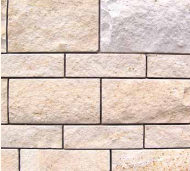
↑ Verblendmauerwerk Ansicht »Gespalten«
