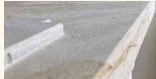
← Fensterbank mit Gefälle und Gewändeaufständen
