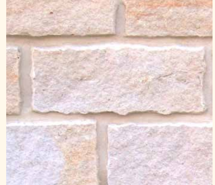
↑ Verblendmauerwerk Ansicht »Rustikal«
