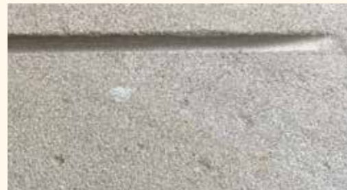
← Wassernase einseitig, beidseitig oder umlaufend, mit oder ohne »Totlauf«
