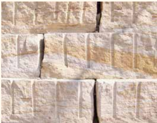
Terrassierung eines Hanges mit Blockmauerwerk aus Haardter-Sandstein – schafft nutzbare Stufen
