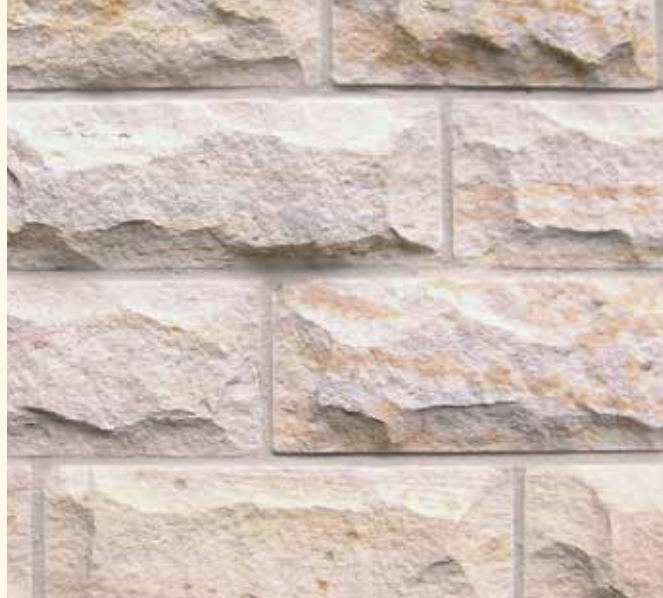
↑ Verblendmauerwerk Ansicht »Bossiert«
